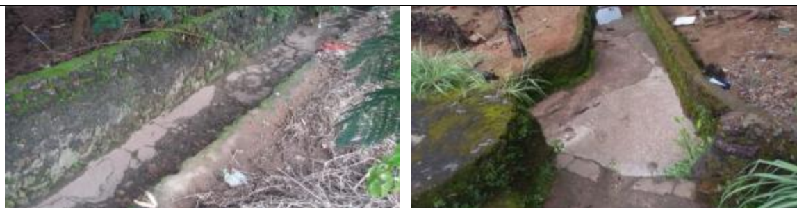
Figura 372 - Rua 02- Caneleta A Céu Aberto
