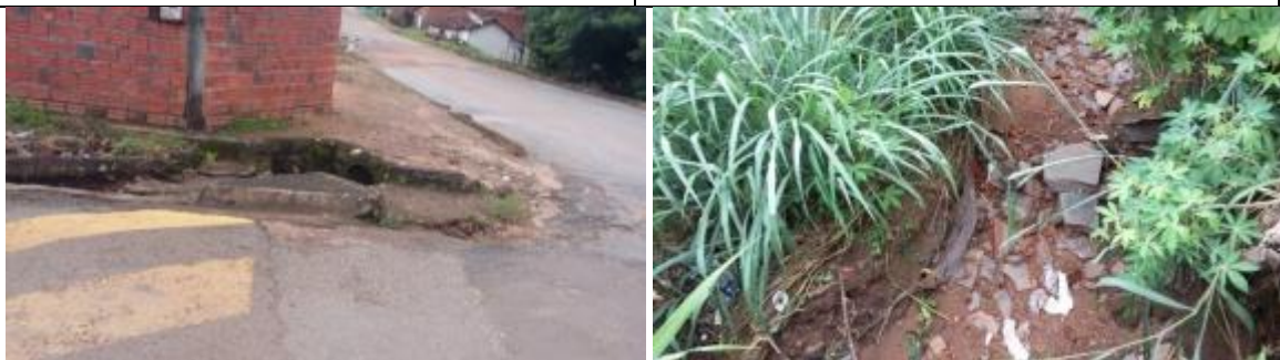
Figura 371 - Rua 02 -Bueiro Esquina
