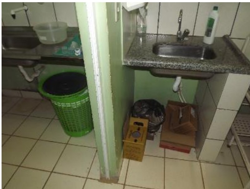
Figura 422 - Armazenamento interno na unidade de saúde
