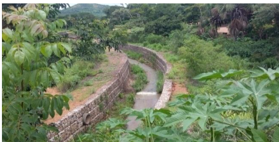
Figura 233: Vista da Avenida Bernardo Sayão sobre o canal do córrego pernada.
