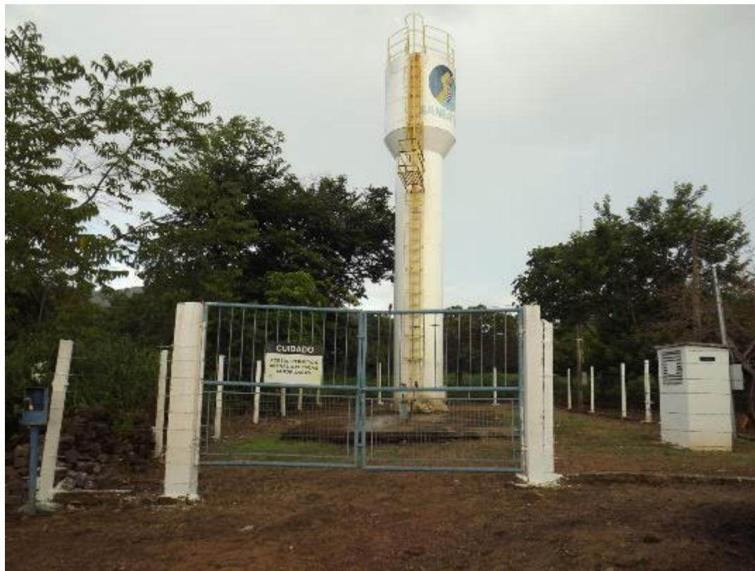
Figura 183 - Área do Poço Tubular Profundo e do Reservatório – Vila Santana
