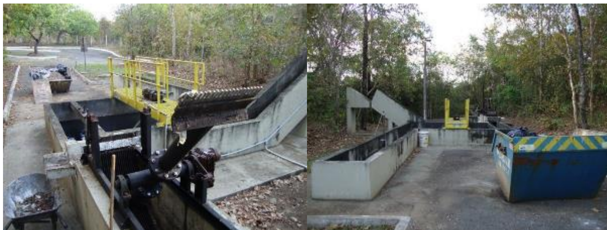
Figura 187 - Tratamento Preliminar: Gradeamento e Desarenador
