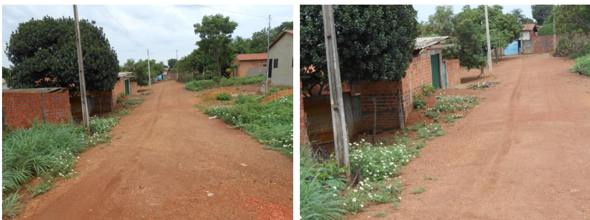
Figura 347 - Rua Alemanha Água invade casas
