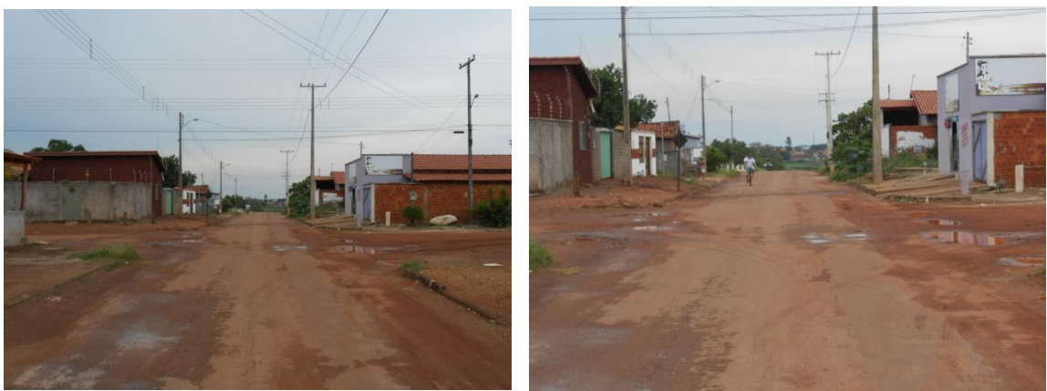
Figura 308 - Rua 62 N° 888 Água invade casas
