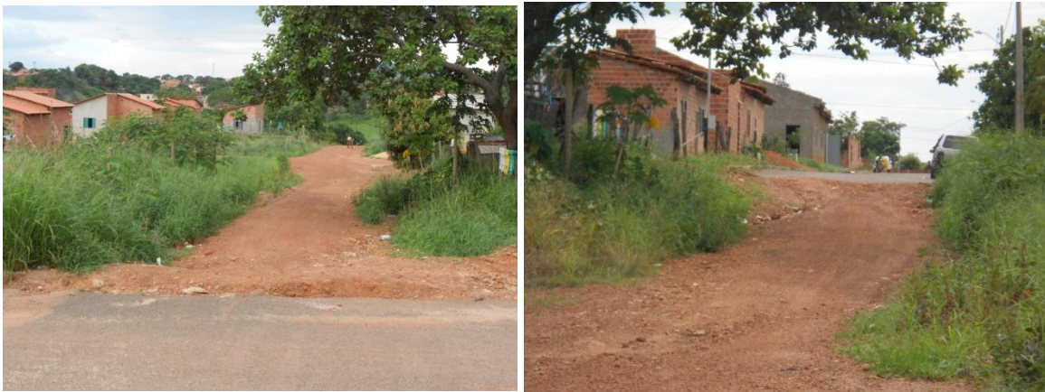
Figura 299 - Rua 18 com Rua Fernandinho
