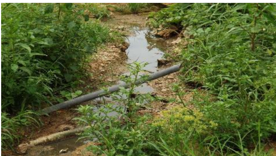
Figura 198 - Esgoto Distrito de Santana
