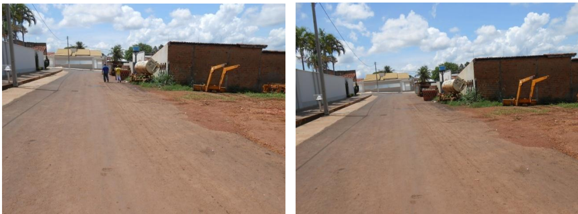
Figura 275 - Avenida Dom João VI Empossamento
