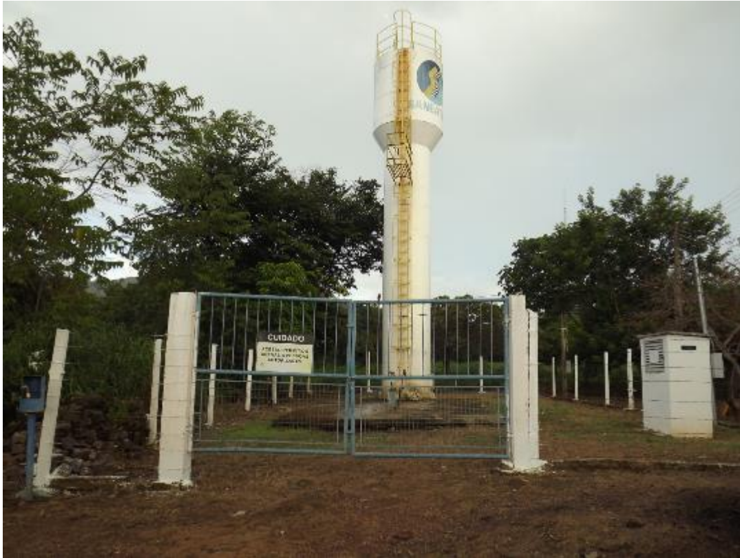
Figura 169 - Área do Poço Tubular Profundo e do Reservatório – Vila Santana
