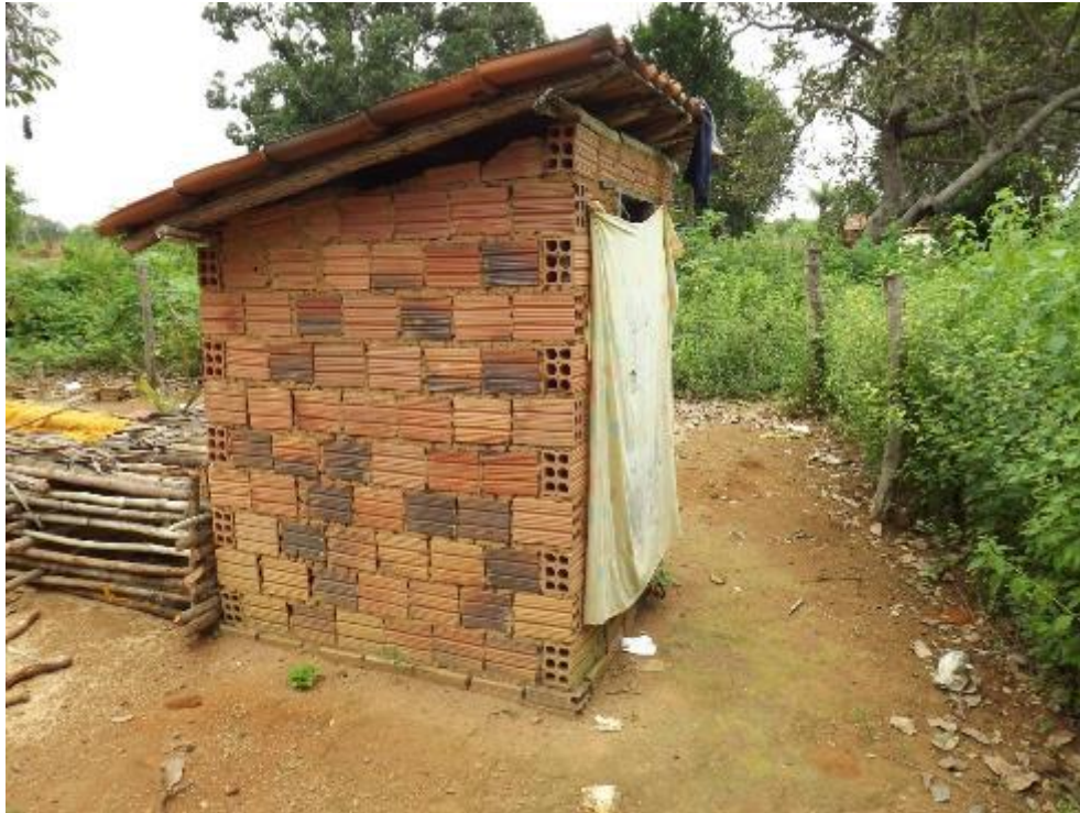
Figura 201 - Esgoto Distrito de Santa Luzia
