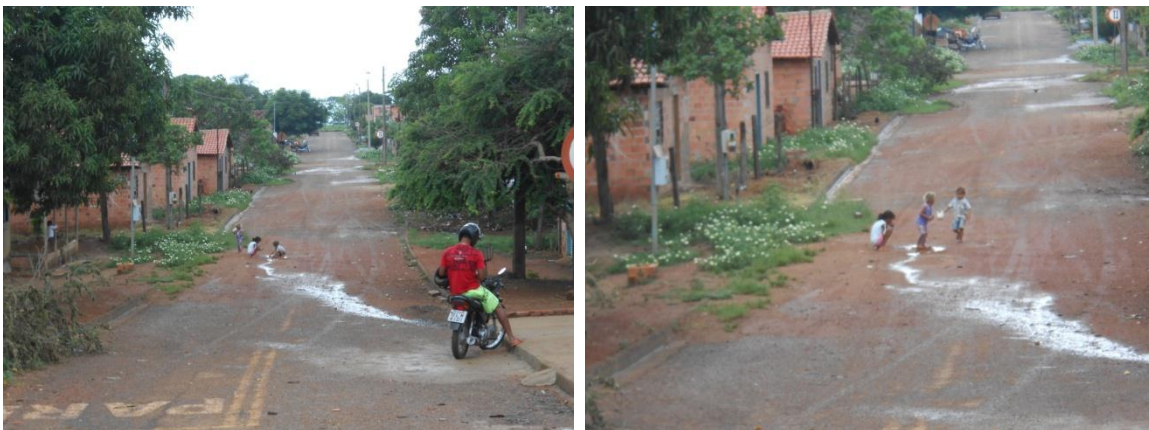
Figura 352 - Rua Holanda Nº2000
