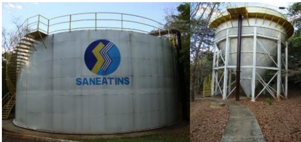
Figura 188 - Reator UASB e Floccodecantador
