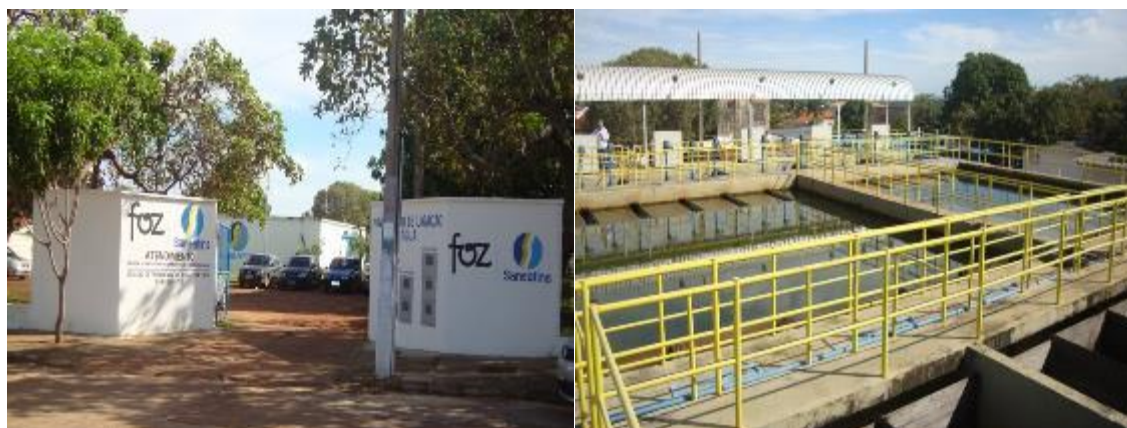
Figura 179 - Estação de Tratamento de Água – ETA-001
