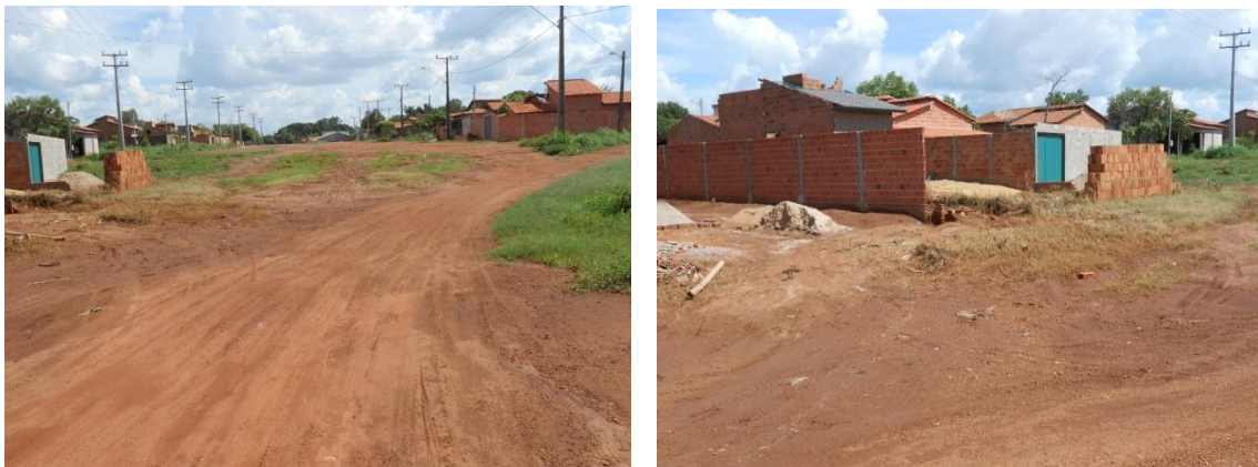
Figura 251 - Rua 07 esquina com a Av. A Água correndo no período chuvoso
