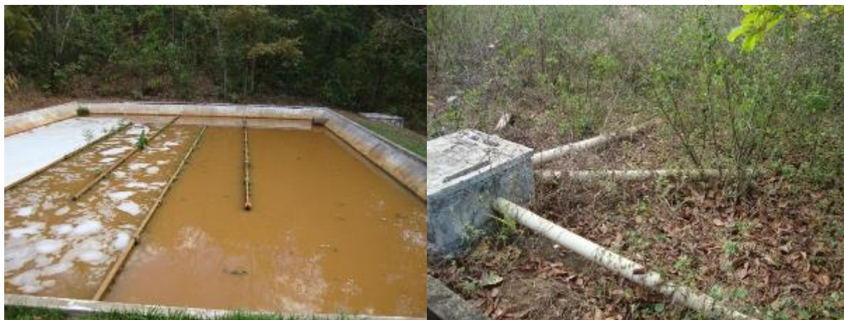
Figura 190 - Tanque de Desinfecção e Disposição Controlada no Solo
