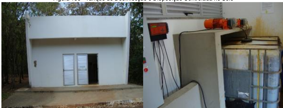
Figura 190 - Tanque de Desinfecção e Disposição Controlada no Solo
