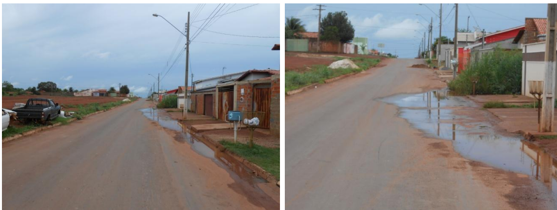
Figura 315 - Rua Perimetral Sul
