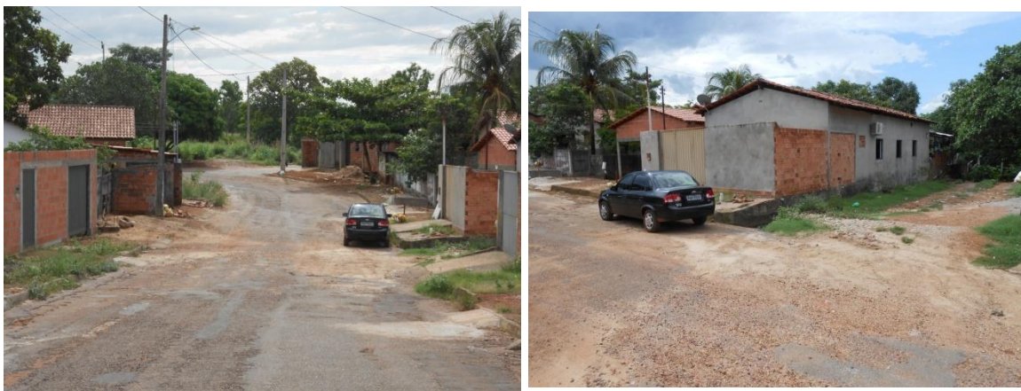
Figura 294 - Rua Perimetral Nº 1396
