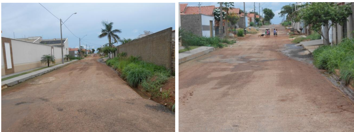
Figura 314 - Rua C Nº 447
