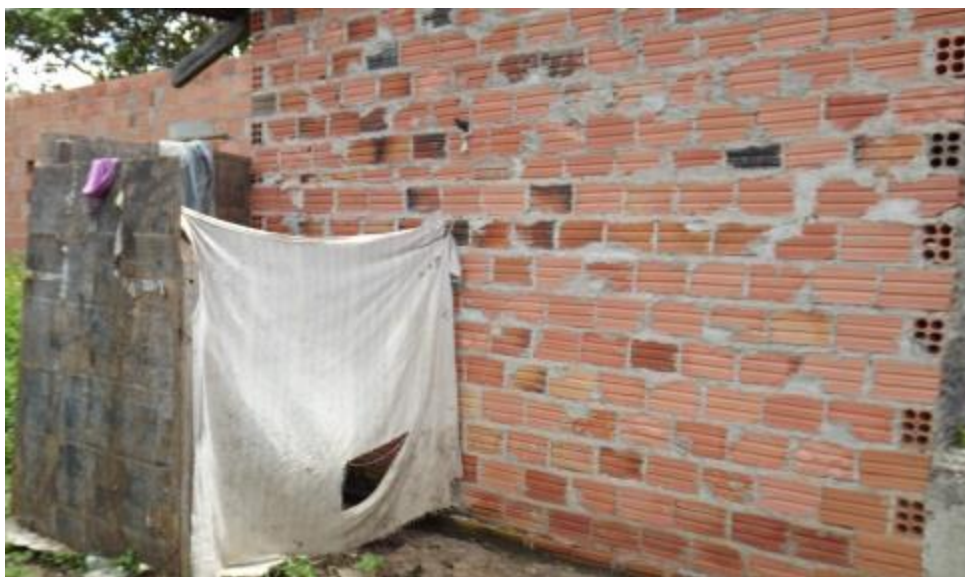
Figura 197 - Esgoto Distrito de Santana
