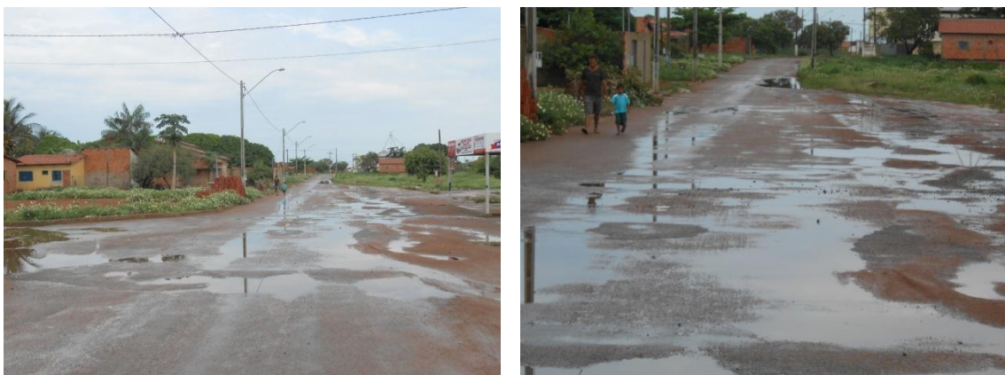
Figura 337 - Rua Suíça (em frente ao posto policial)
