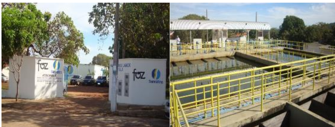
Figura 165 - Estação de Tratamento de Água – ETA-001
