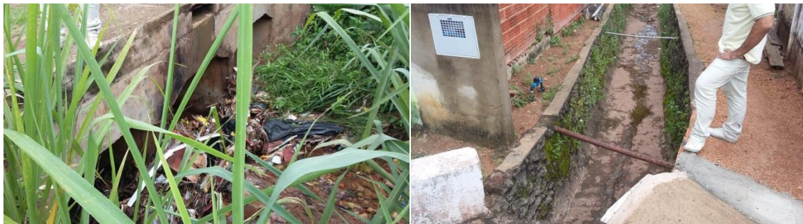
Figura 231: Galeria da rua Tocantins e canaleta da avenida 13 de maio, respectivamente.
