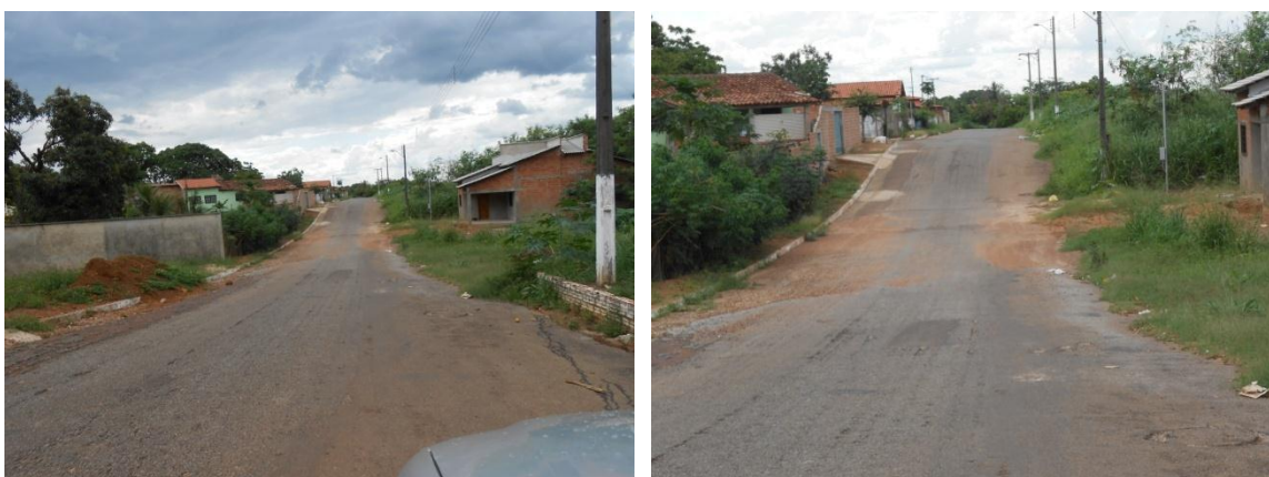
Figura 292 - Rua 15 Água invade casas
