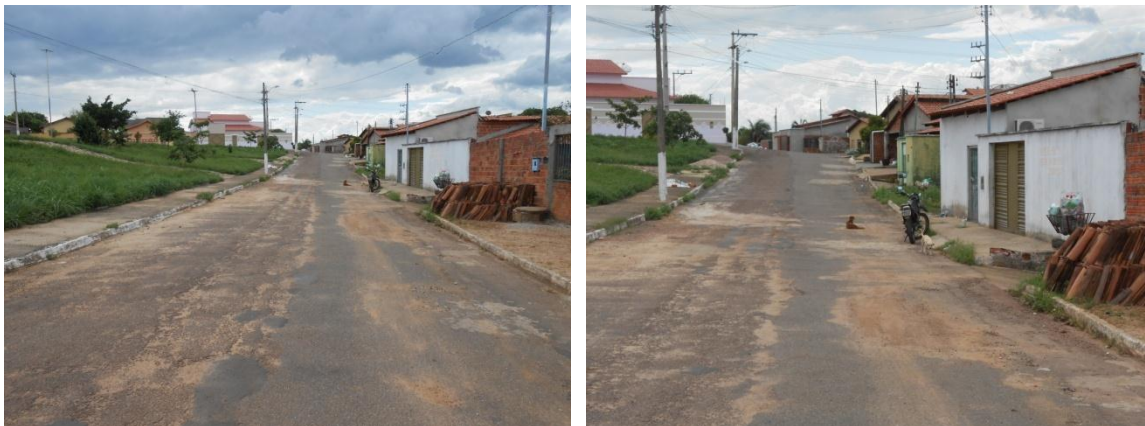
Figura 293 - Rua perimetral Nº1090
