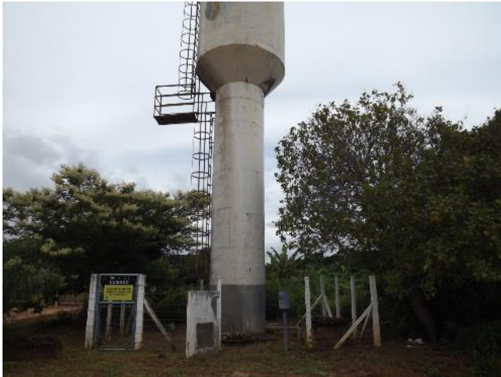
Figura 171 - Reservatório Metálico Elevado – Distrito de Santa Luzia
