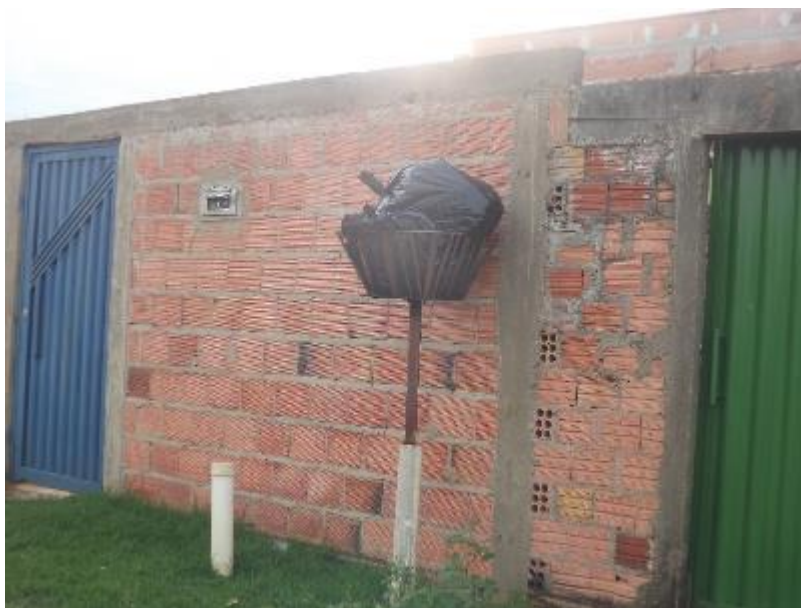
Figura 419 - Lixeira instalada em um local mais alto
