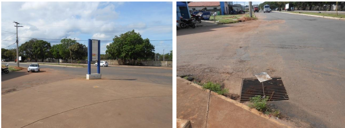
Figura 266 - Rua 20 com Av. Bernardo Sayão Empossamento
