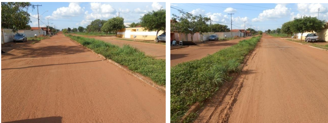
Figura 248 - Avenida Taubaté Drenagem por dentro dos lotes
