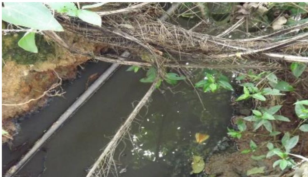
Figura 199 - Esgoto Distrito de Santana
