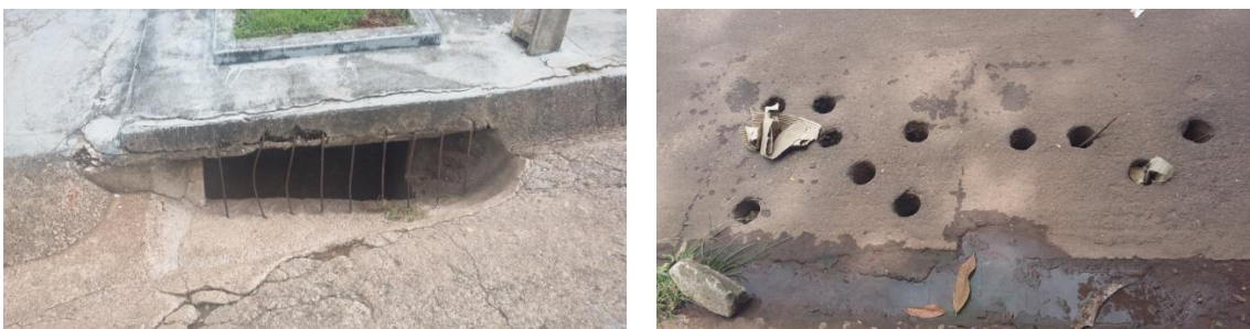
Figura 226: Rua Amâncio de Moraes e rua L 02, respectivamente (Bela Vista).
