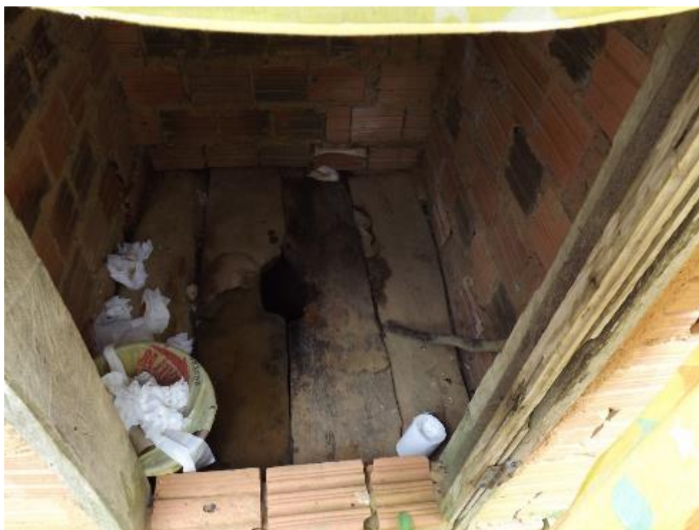
Figura 200 - Esgoto Distrito de Santa Luzia
